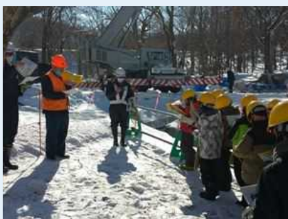
工事現場内での説明の様子
