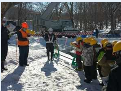
工事現場内での説明の様子
