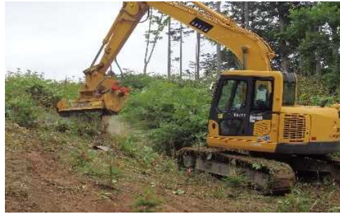
クラッシャーによる下刈り作業
