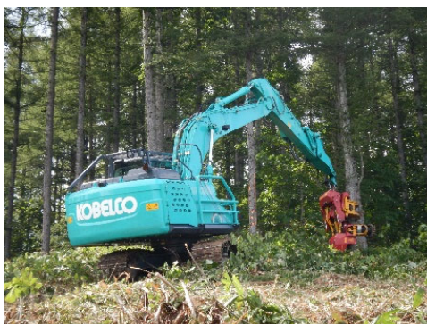
列状間伐のデモンストレーション
