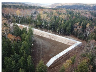
コンクリート導流堤
