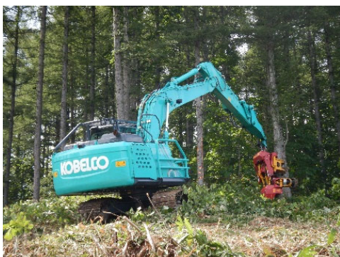
列状間伐のデモンストレーション
