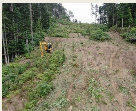
写真7：クラッシャ下刈の仕上がり状況（写真右側が機械下刈）
