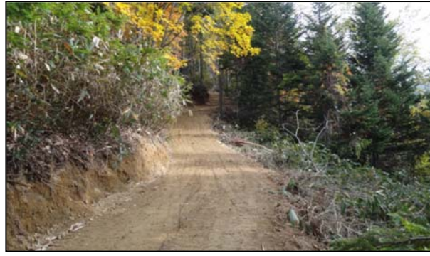
転圧が十分施された堅固な路体
