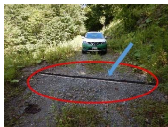
木製路面排水工
