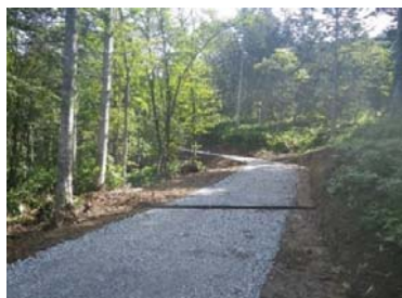
平成30年度新設 林業専用道
