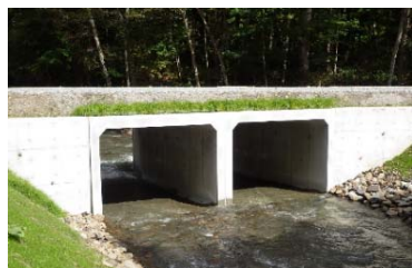
実施後（ボックスカルバート）
