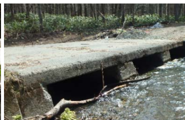
工事前（河床路）
