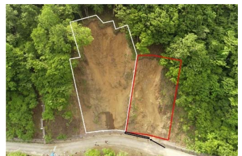
赤で示された区域が被害拡大箇所 日高南部森林管理署
