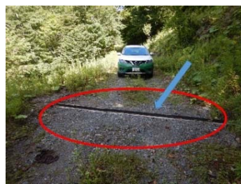
木製路面排水工
