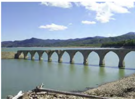
タウシユベツ川橋梁
