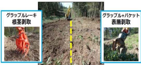
図2 大型機械による地拵方法の違いを検証する試験地
