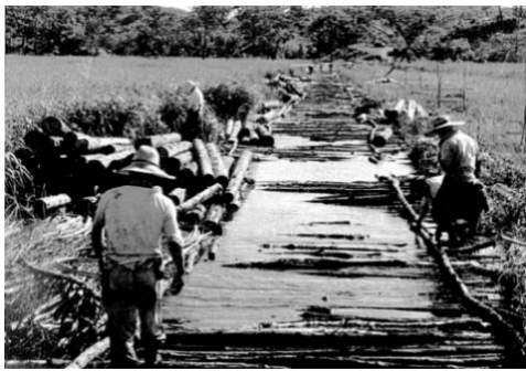
湿原を渡る浮き橋の敷設
