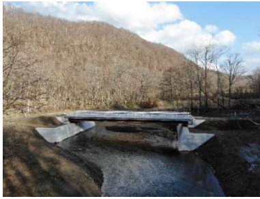
東川右線林道災害復旧工事（橋梁工）
