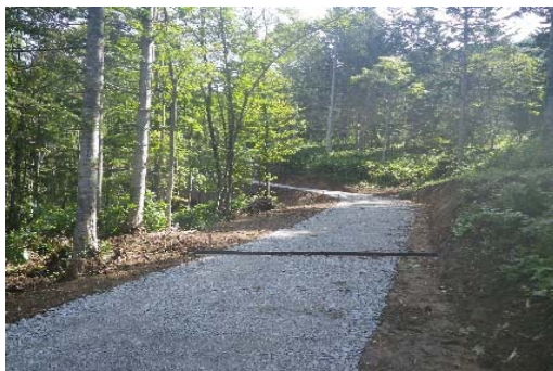
田中工場の沢林道小錫の沢支線二の沢分線(林業専用道)新設工事
