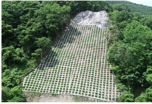
紋別川(2185林班)治山工事
