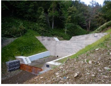
コンクリート谷止工
