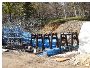
完成が待たれる小林川の スリットダム
