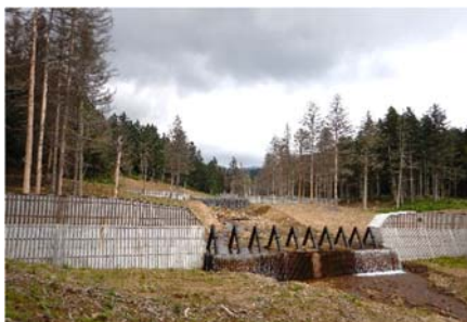
流木を捕捉するスリットダム (三国沢 平成30年3月完成)
