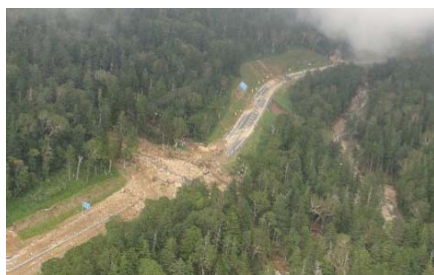
国道274号の土砂流出 (平成28年9月撮影)
