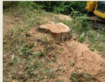
写真8: クラッシャで破碎した伐根
