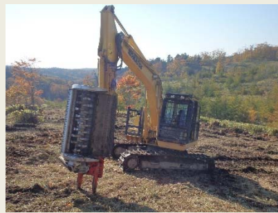
写真2: 油圧ショベルクラッシャー
