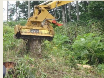
写真7: クラッシャによる伐根破碎
