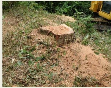
写真8: クラッシャで破碎した伐根
