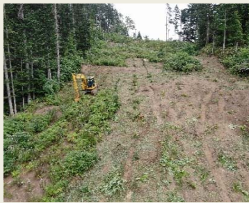
写真9: クラッシャ下刈りの仕上がり状況(写真右側が機械下刈り後の状況)
