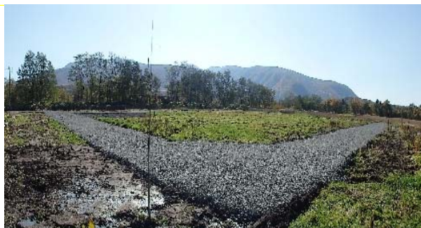
完成した共同土場（ストックヤード）
