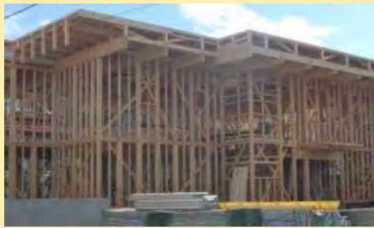
構造材に道産トドマツを使用した建物 (宗谷署庁舎平成29年11月撮影)
