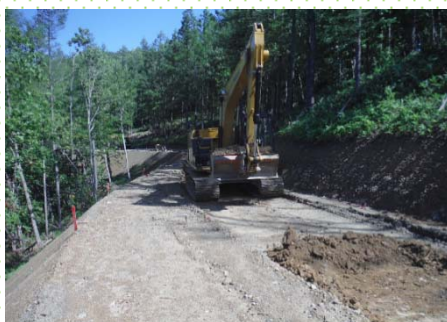
令和元年9月施工状況(西紋別支署)
