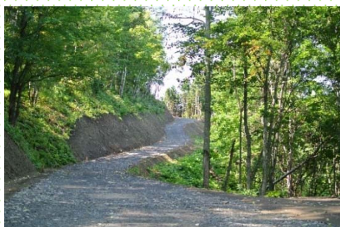
平成30年度施工状況(西紋別支署)
