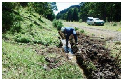
側溝の清掃作業
