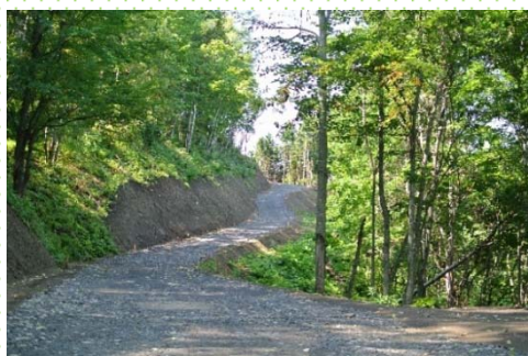
平成30年度施工状況(西紋別支署)
