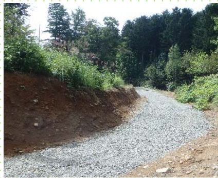
平成30年度施工状況（石狩署） 森林整備推進協定地区内の林道
