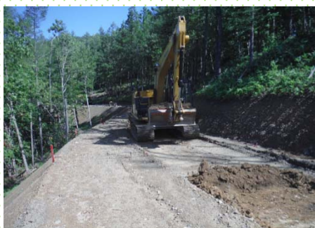
令和元年9月施工状況(西紋別支署)
