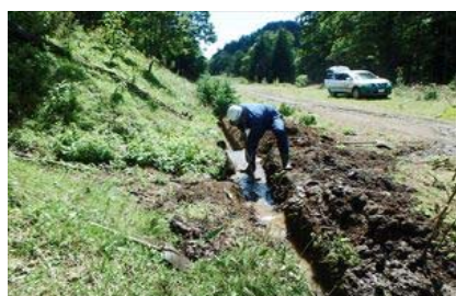
側溝の清掃作業
