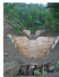
平田内地区の治山工事現場
