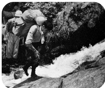
写真③ 測量器械やコンクリート製標識を背負って運搬
