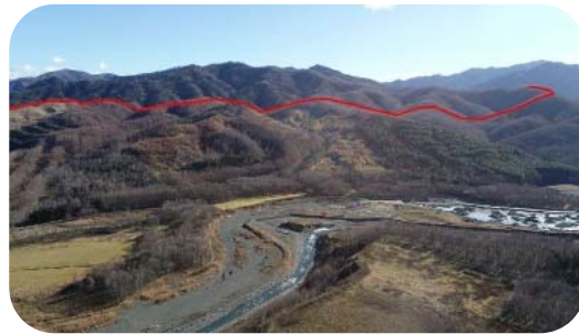
写真⑥ 境界標は崖や峰、豪雨等による災害により現場へ行くのが困難な場所もある。（赤い線が境界）
