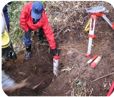
写真⑤ 境界標を設置している様子
