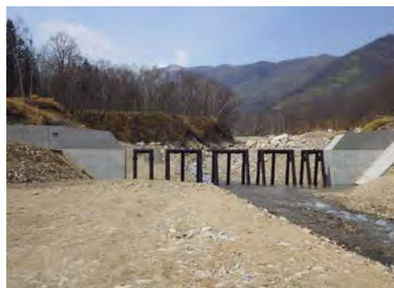
完成状況 スリット式治山ダム
