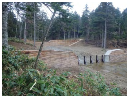
完成状況 上段 治山ダム 下段 スリット式治山ダム
