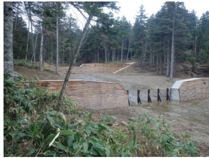
完成状況 上段 治山ダム 下段 スリット式治山ダム
