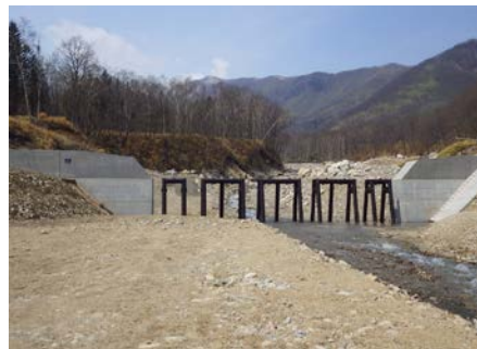
完成状況 スリット式治山ダム
