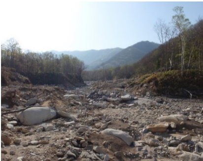
被災当時の状況
