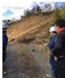
ドローンによる被災地林道調査
