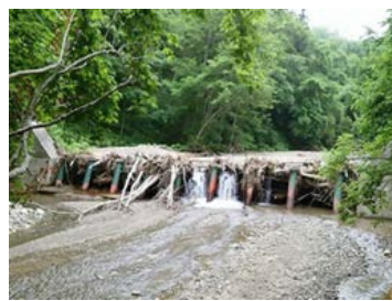
流木捕捉式治山ダム (十勝西部森林管理署)
