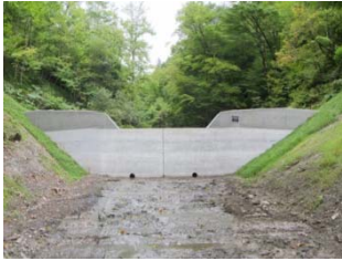
コンクリート谷止工
