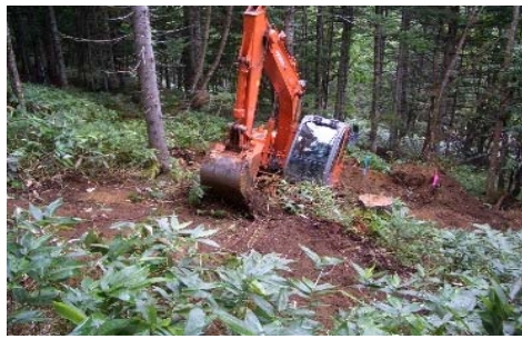
機械による地がき作業
