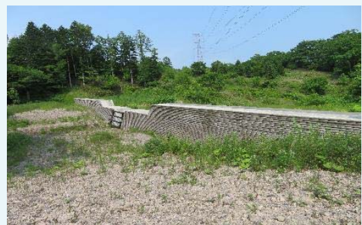
昨年の現地見学会で見学した治山ダム (苫小牧市)
