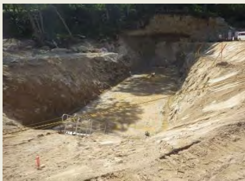
施工中の状況(H29.7.26 現在)
