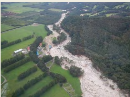
被災直後の下流市街地の被災状況
