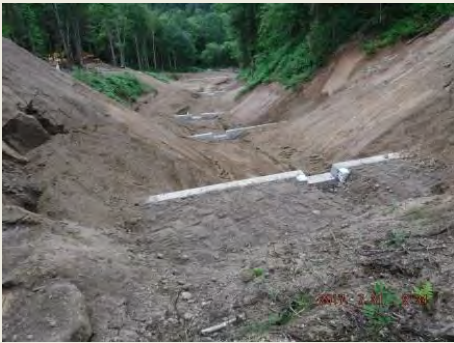
崩壊した山腹斜面に対し土留工施工中の状況
