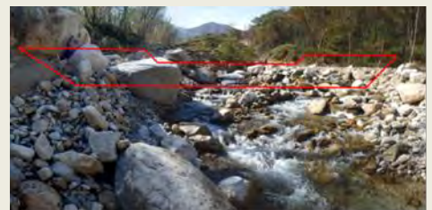
治山ダムを計画 （赤線はコンクリート谷止2号箇所）
