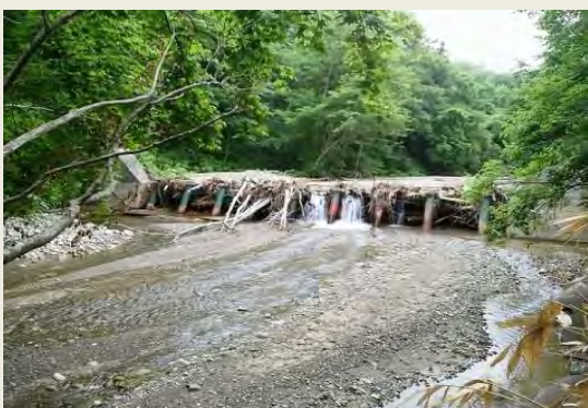
大樹町で施工したスリットダムが流木を捕捉した状況
