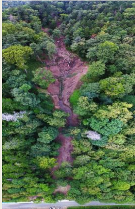
被災直後の山腹斜面の崩壊状況
