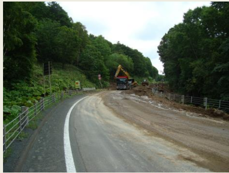
被災直後の国道39号線流出した土砂撤去状況
