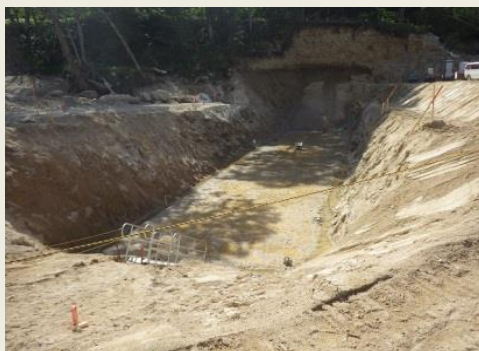
施工中の状況(H29.7.26 現在)
