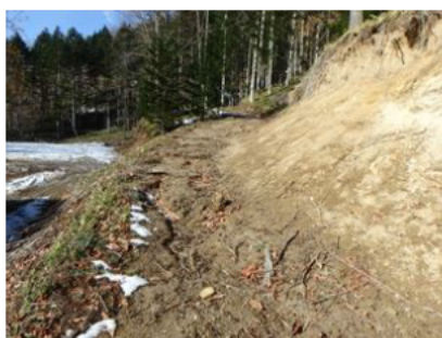
融雪と台風通過後の森林作業道
