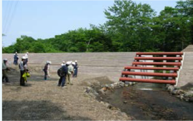
覚生川上流部の治山施設見学
