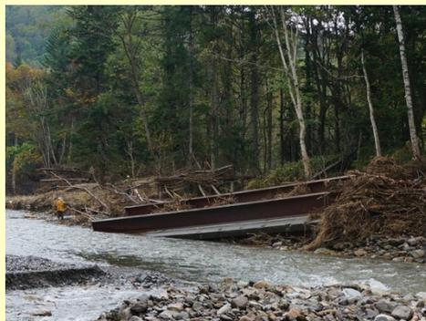
■被災後約100m下流に流された橋梁部
