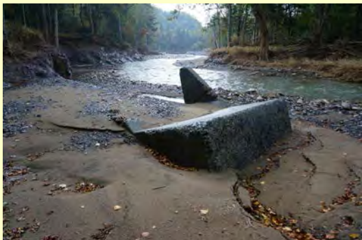
■被災後 約200m下流に流された橋台部
