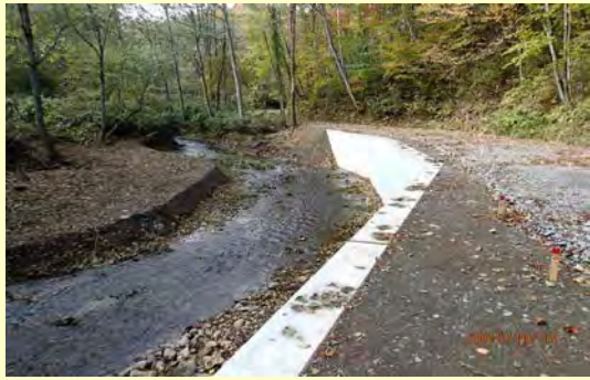
■復旧イメージ草笛林道災害復旧工事（千歳市 H28 年竣工）
