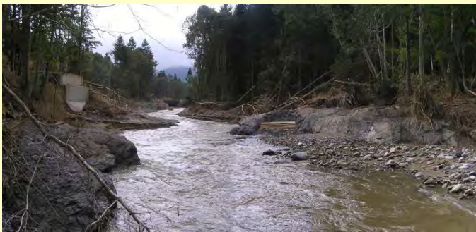
■被災後 増水により橋が完全に流出（下流部から撮影）
