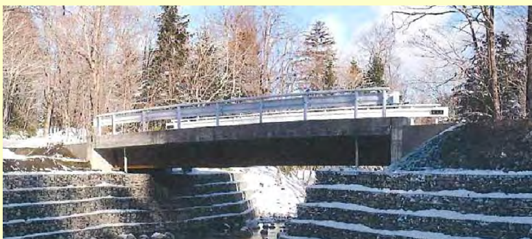
■復旧後のイメージ 金山橋（恵庭市国有林H28竣工）
