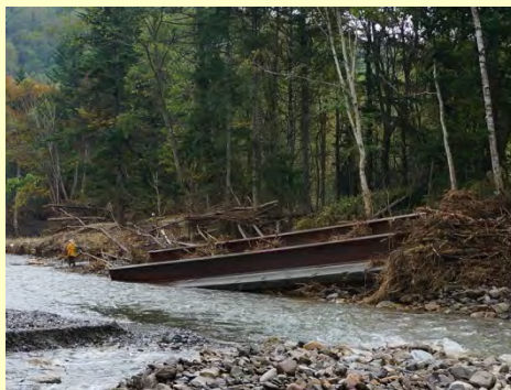
■被災後約100m下流に流された橋梁部
