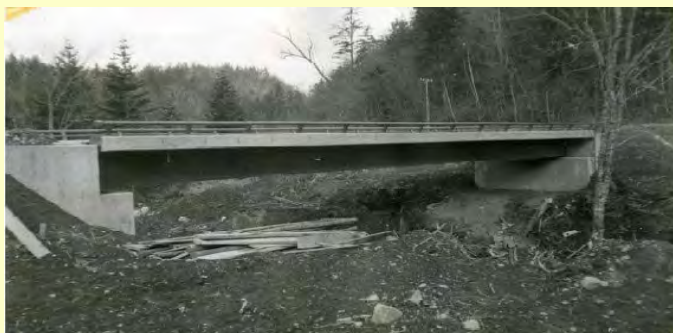
■被災前 金の沢橋竣工時（昭和44年完成当時）
