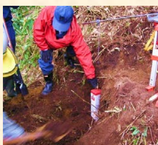
(写真⑦) 境界標識を再設置している様子
