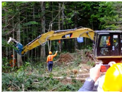
グラップルウインチによる全木木寄せの様子（愛別町）
