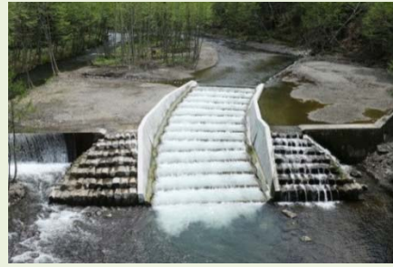
【斜里川治山工事】
