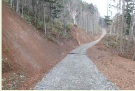
【樽岸林道（林道専用道）新設工事】 後志署
