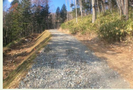
【協和左2号林道（林道専用道） 外新設工事】 上川中部署
