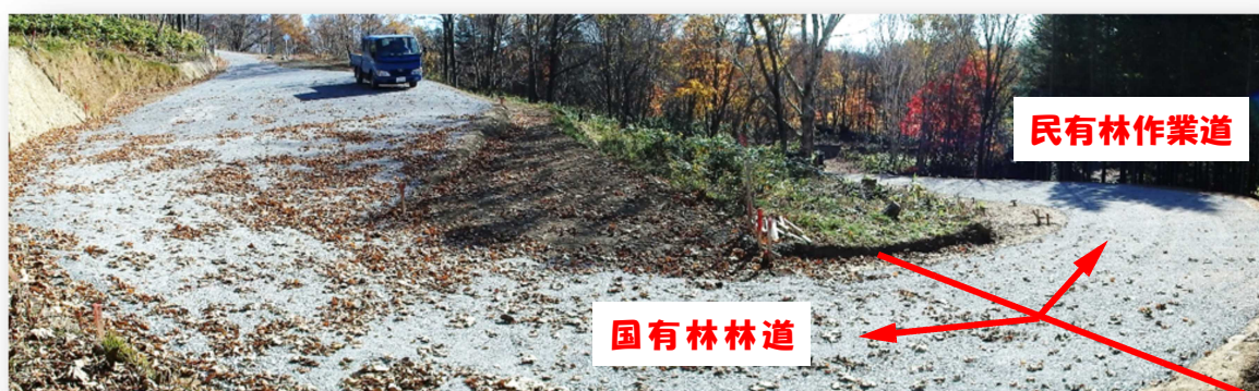
(民有林作業道と国有林林道を接続した効率的な路網整備)
