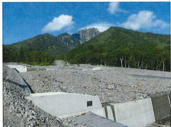
大空沢川中流部に溜まった崩壊土砂から住民や道路を守るため、今までに渓間工 33 基、護岸工 3,800m を施工しています。
