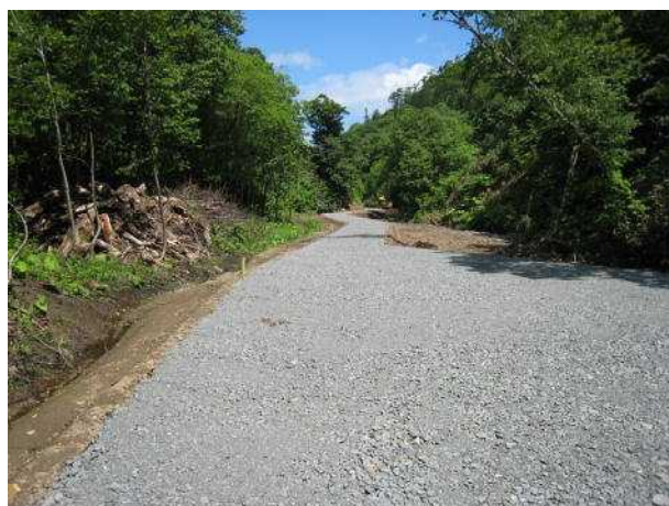
林業専用道新設工事
