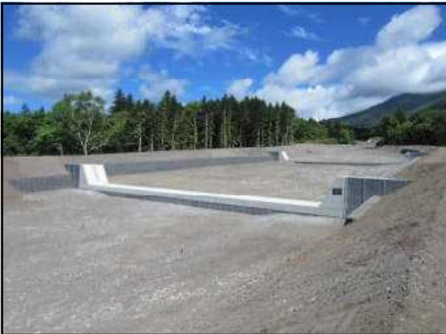
また、地元からの強い要請で平成16年（2004）から溪床内の土砂を鋼製枠に中詰めする「鋼製護岸工」を実施するとともに、溪床にたまった土砂・岩石を運び出し作業道に敷き詰めるなど、土砂を取り除いて溪床を下げ森林地帯と高低差をつける工事を実施しています。
