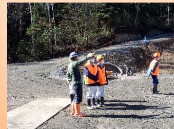
治山工事施工箇所を見学
