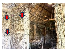
チセを葺くコシを押さえる サクマ (広葉樹のしばを使用)
