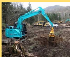
① 除根箇所を掘削
