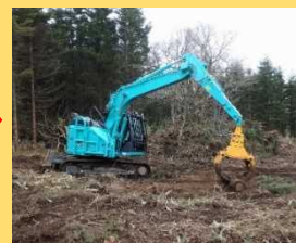
③ 掘削土砂で整地
