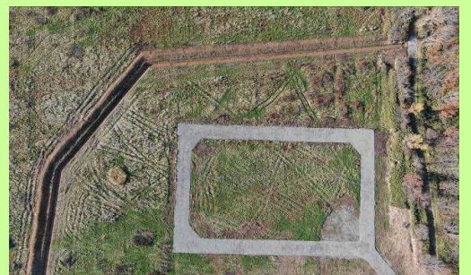
上空から見たストックヤード
