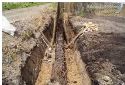
柵設置にかかる床堀
