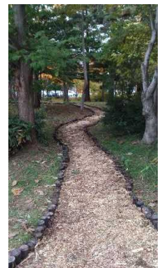
写真4 遊歩道の縁の作成
