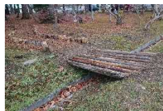
写真5 見本林入口の橋
