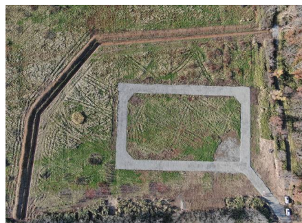
図-2 共同土場（ストックヤード）
