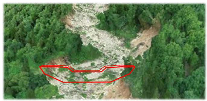
(測量箇所オルソ画像)
