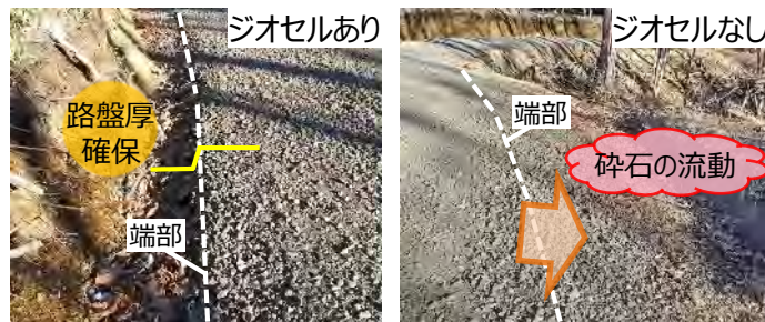
写真2 ジオセル設置の有無の比較
